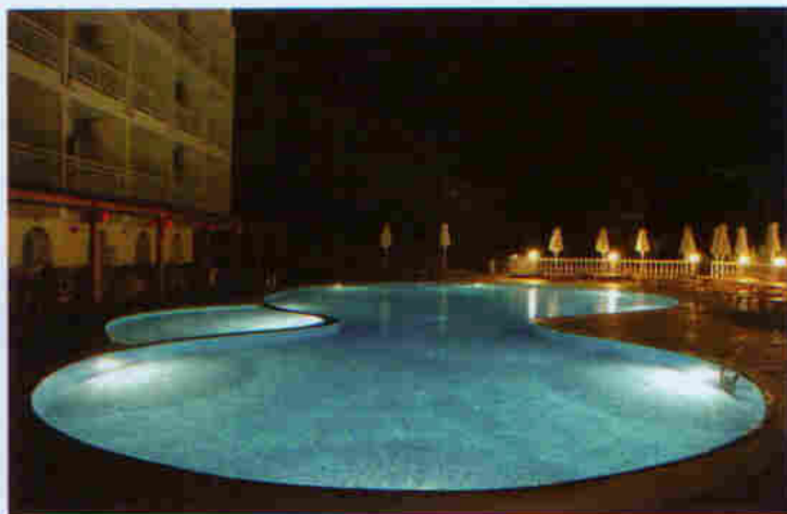
ΑΠΟΨΗ ΤΟΥ ΕΞΩΤΕΡΙΚΟΥ ΧΩΡΟΥ ΜΕΤΑ ΤΗ ΔΙΑΜΟΡΦΩΣΗ
